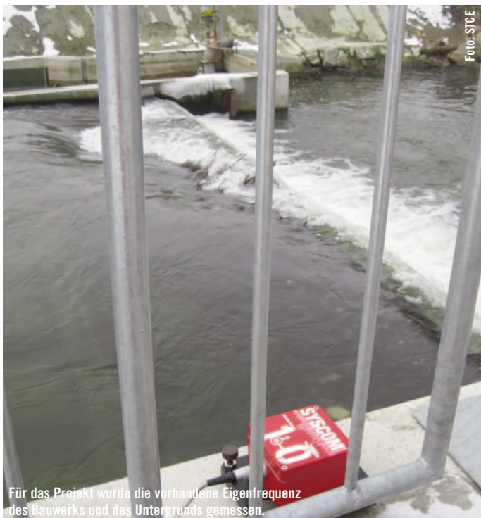
Das zweite Restwasserkraftwerk der dreiteiligen Kraftwerksanlage verfügt über eine Fallhöhe von 2,3 Meter
