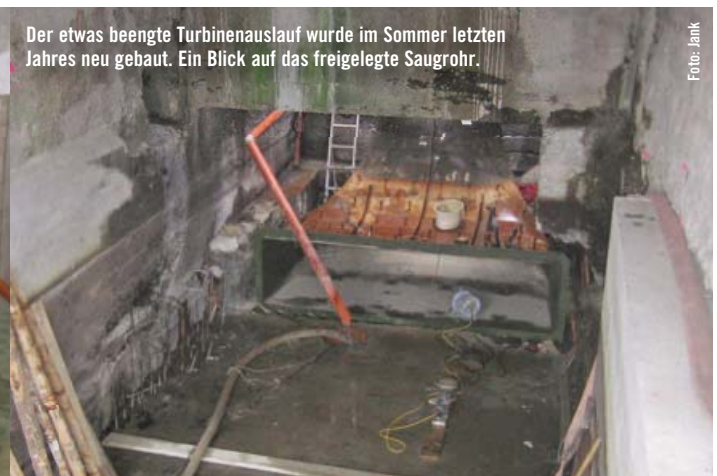
Der alte Maschinensatz aus 1955: Die Turbine war mit einem Stirnkegelradgetriebe verbunden.
